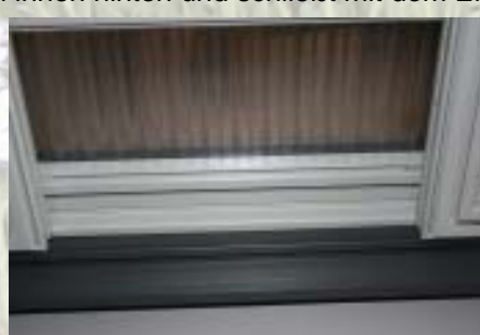
Ansicht von innen nachdem das Türelement wieder eingehängt wurde.
